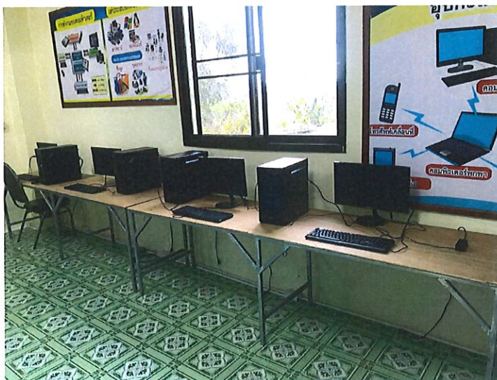
รูปที่ 9 เดือนกุมภาพันธ์ 2562 ติดตั้งสายไฟและสายสัญญาณอินเทอร์เน็ตให้กับโรงเรียนขนาดเล็ก
